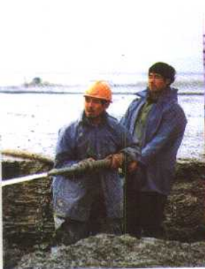
机工操作泥浆泵施工
