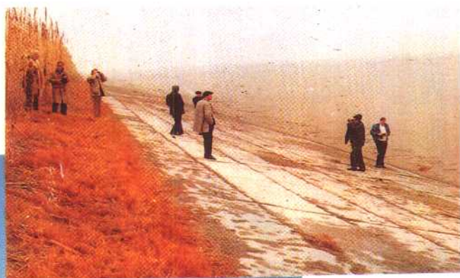
水泥竹筋砼护坡 外国专家组考察
