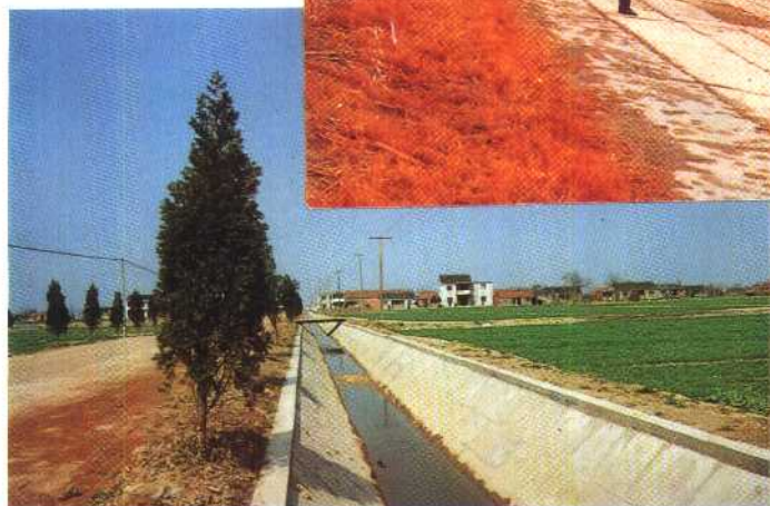
垦区水泥板水渠平直畅通
