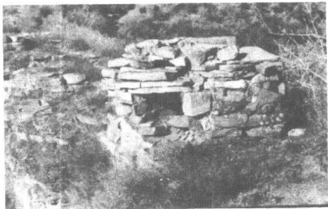
黄崖洞周围工事④
