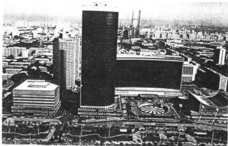
图 1-7 北京世界贸易中心是首都经济效益最好的办公综合楼
