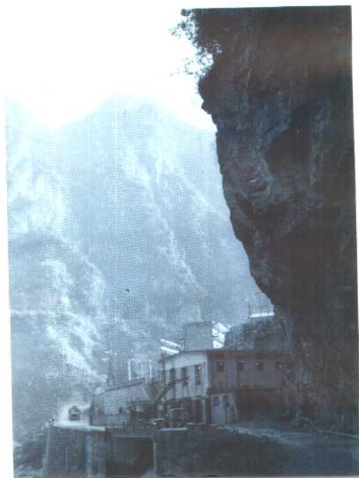
猴子垵水电站
