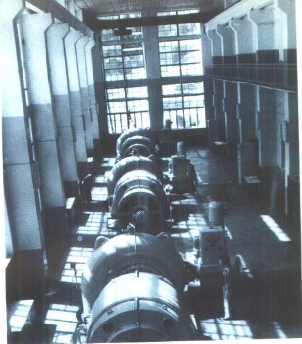
苍坪河水电站发电机房
