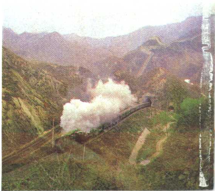
八达岭铁路隧道
