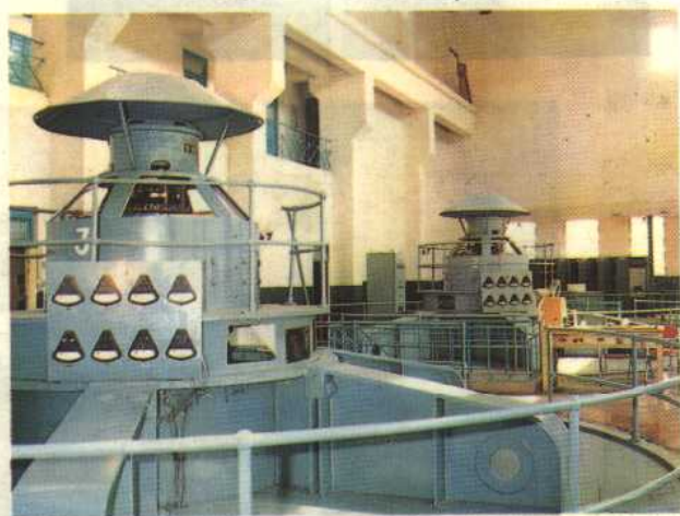
时间作证——724厂1958年生产的1.5万瓩低水头发电机 目前仍在河北省平山县岗南水库正常发电
