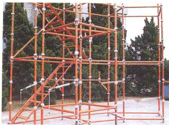
支撑的另一种形式——碗扣式支撑
