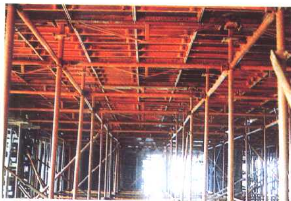
楼盖模板支撑情景
