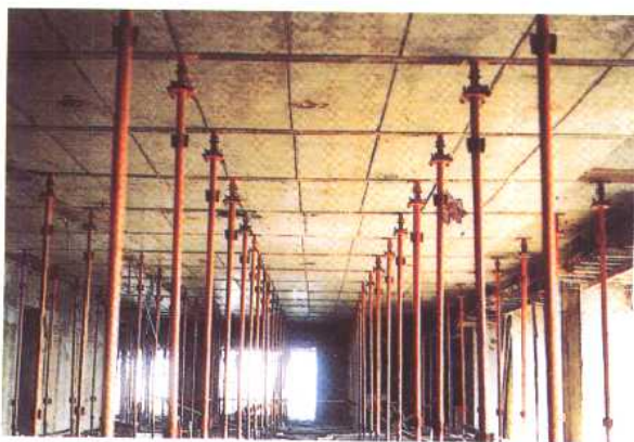
拆除模板支撑保留
