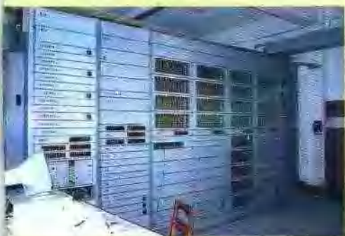
新桥邮电所程控电话电脑控制台
