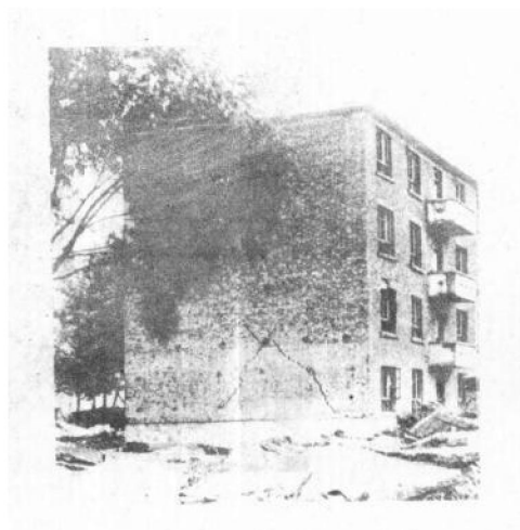
图 1-13 墙体斜裂缝
