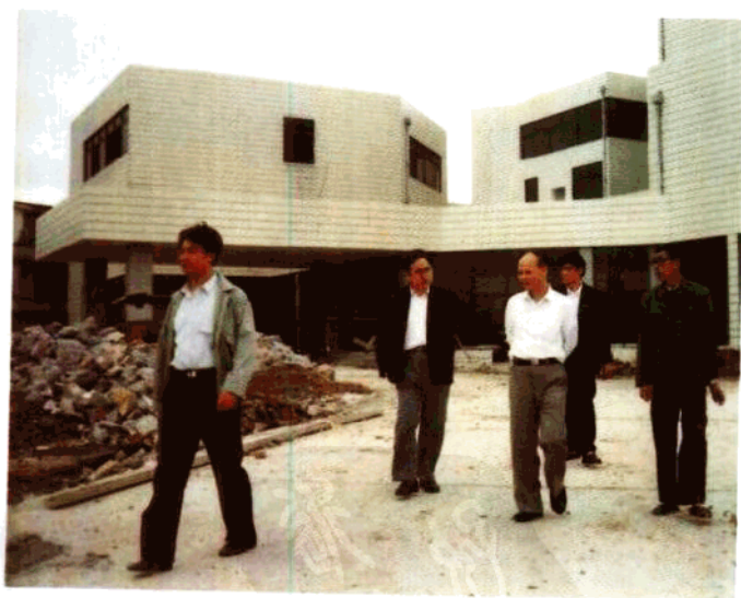
图七 原自治区广电厅厅长邓生才（二排中）视察安新洲广播电视大楼工地。
