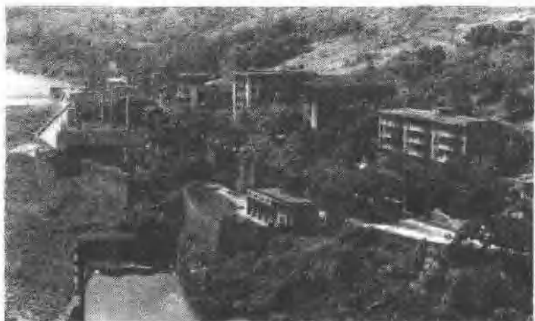
綦江盖石洞电厂
