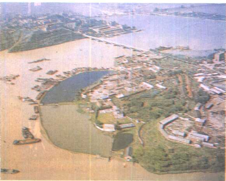
葛洲坝水利枢纽工程
