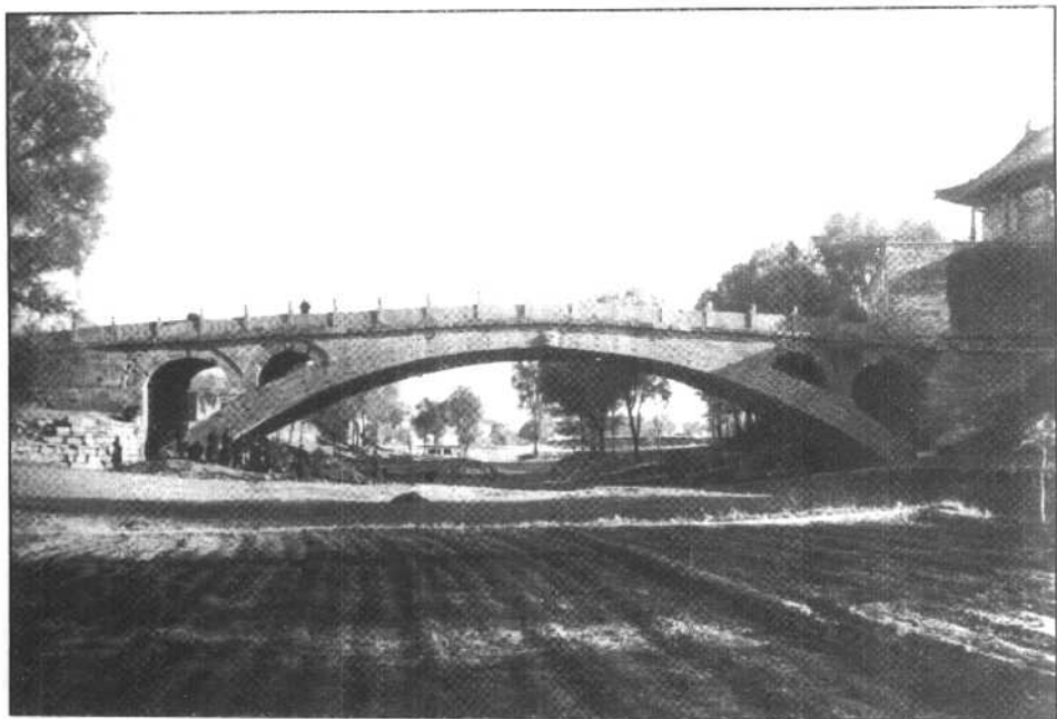
河北正定的赵州桥，是世界上已知的第一座弧形的和开拱的石桥。
