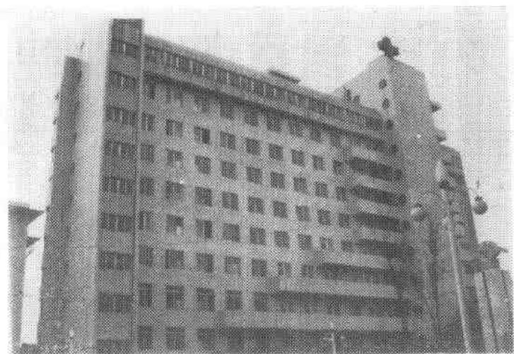
贵阳市第一人民医院住院部大楼
