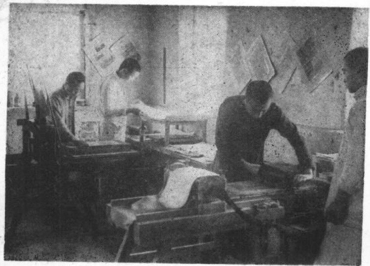
在敌后游击战争的环境中，铅印出版书报，是很不容易的。但是各解放区的工人，都克服了种种困难，制造出铅印机器，坚持出版各种书报。图为晋察冀工人制造的平版印刷机。
