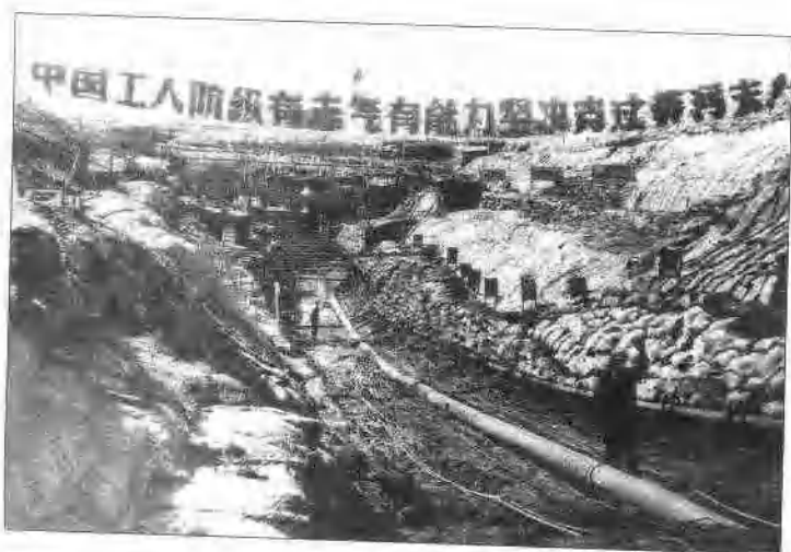
1969年， 胜利油田首 次实施输油 管线穿越黄 河施工，图为 黄河北岸穿 越操作坑
