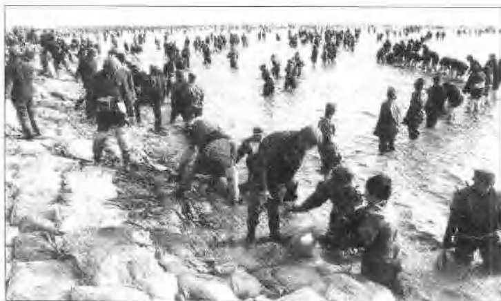
围海造 陆，修筑弧 东防潮大堤
