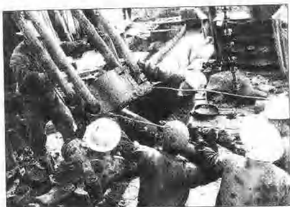
会战初期，石油 职工正在进行下套管 作业的施工现场面
