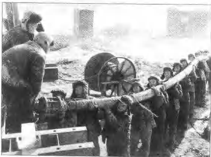
石油职工发扬大庆精神，人拉肩扛，安装设备
