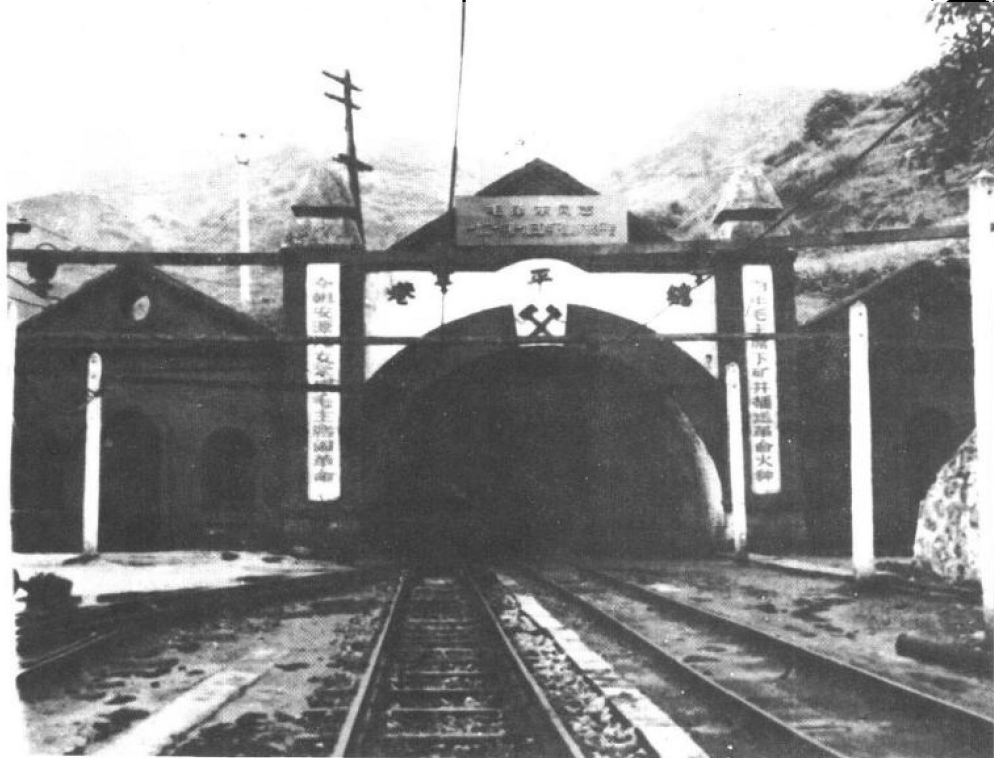
安源煤矿总平巷。
