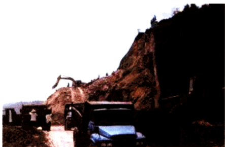
▲ 正在开发建设的绵重公路射洪北段施工现场。
