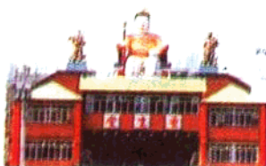
屋顶上巨大的瑶池金母像
