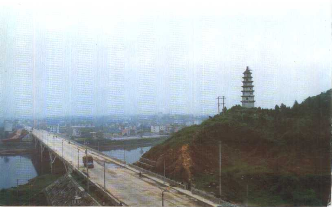
107 国道蒲圻大桥
