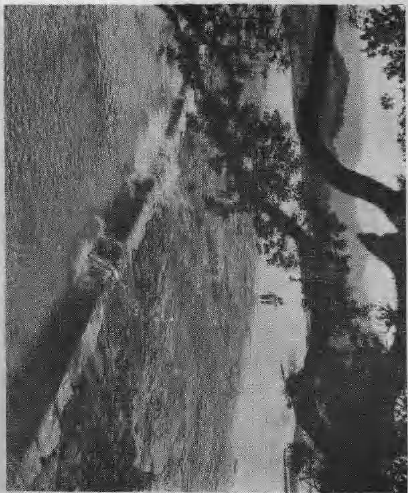
圖二 築在萍湖末端的大小天平柳河壩，形如人字，共長五百米，攔水進入靈渠。
