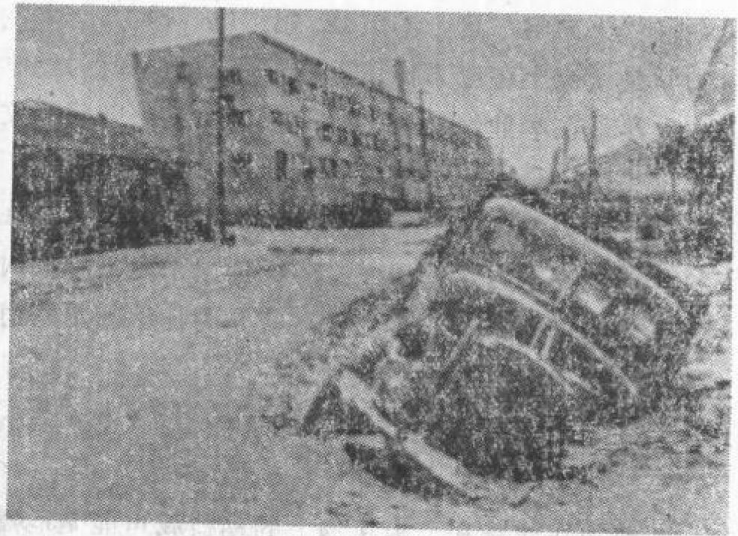
图 1-2 1964年新潟地震中汽车下陷
