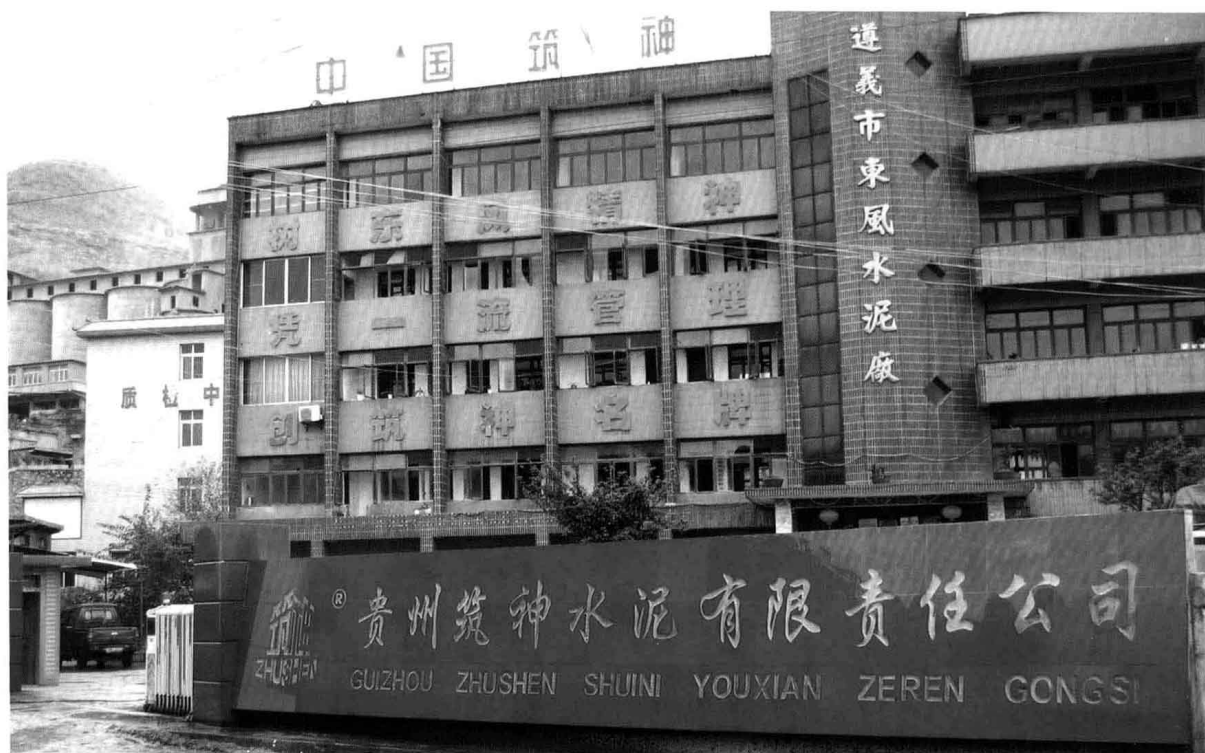
图 - 14 2005年，贵州筑神水泥有限公司
