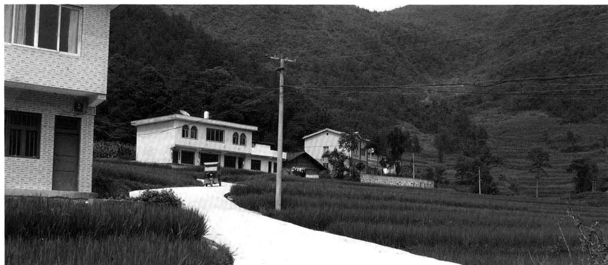
图- 50 新拱村道路硬化
