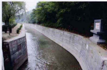
节水改造后的引沁总干渠
