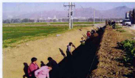
排涝沟工程施工现场
