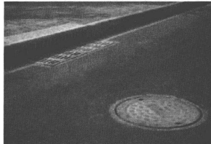
图 1-7 道路路面雨水排水口
