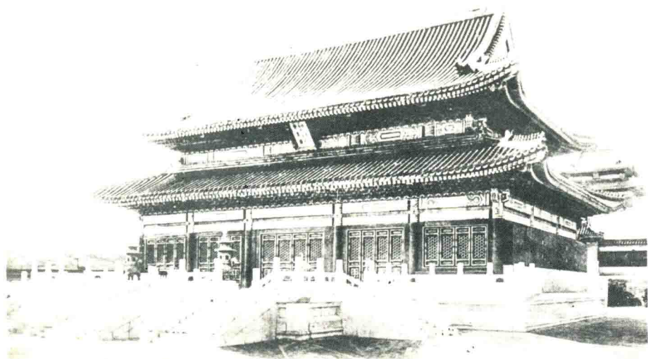
台基、屋身與屋頂構成明顯的三段式造型組合，模仿人的腳、身及頭之意象。
