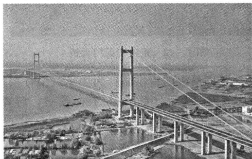
图 1-15 江苏润扬长江大桥
