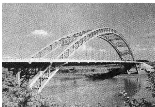
图 1-7 广西三岸邕江大桥
