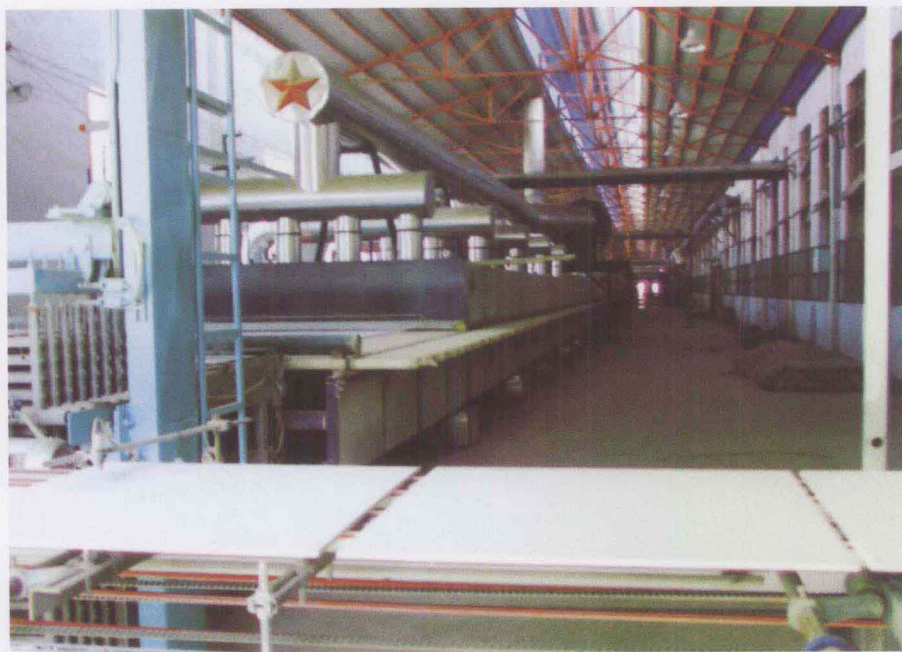
宝丰县洁石建材有限公司生产车间
