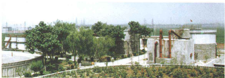
塔岗水库城市供水工程第三水厂
