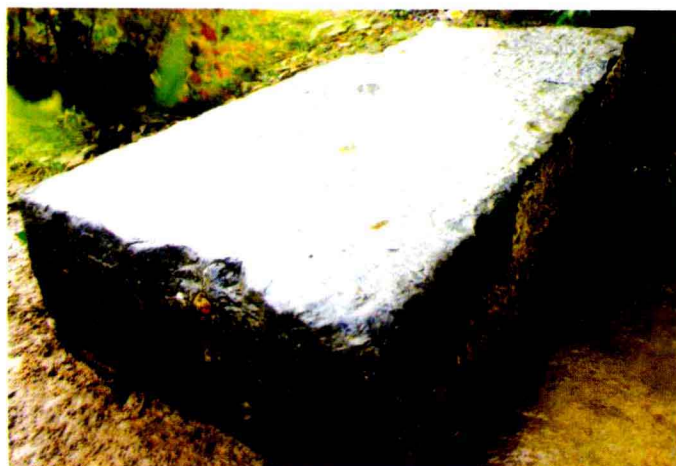
玉仙橋券頂石 長1.04米 厚0.32米 上寬0.70米 下寬0.64米
