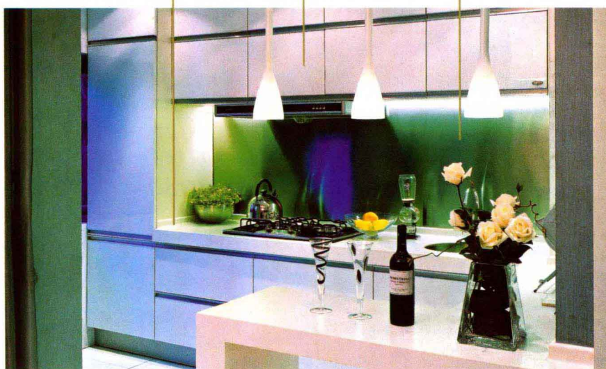
不锈钢方边 横贴饰面板 饰面板喷白漆 釉面砖 批灰面刷乳胶漆 夹板吊顶天花 暗藏灯槽位 人造大理石台面 烤漆板吊柜 绿色聚晶玻璃
