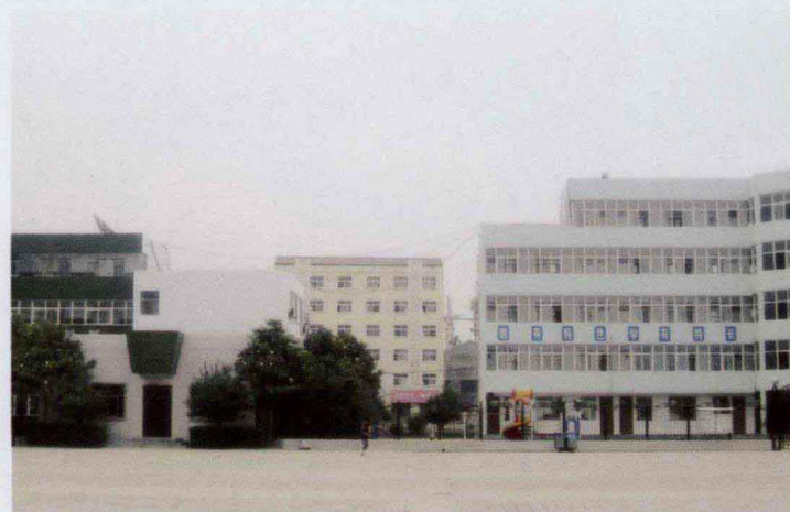
圣源学校教学楼
