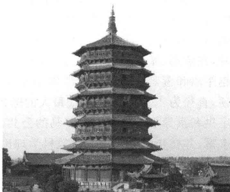
图 0-15 山西应县木塔
