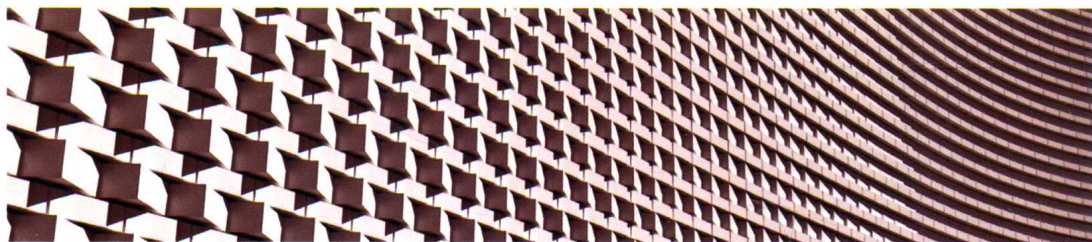
Type B. one row turned according to the end of the lower one with various angle B 类 相邻的两皮砖中，上一皮砖根据下一皮砖的最后一块突出的角度作出不同角度的
