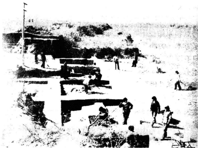
城子崖遗址发掘现场
