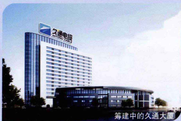
河南久通电缆有限公司 筹建中的久通大厦
