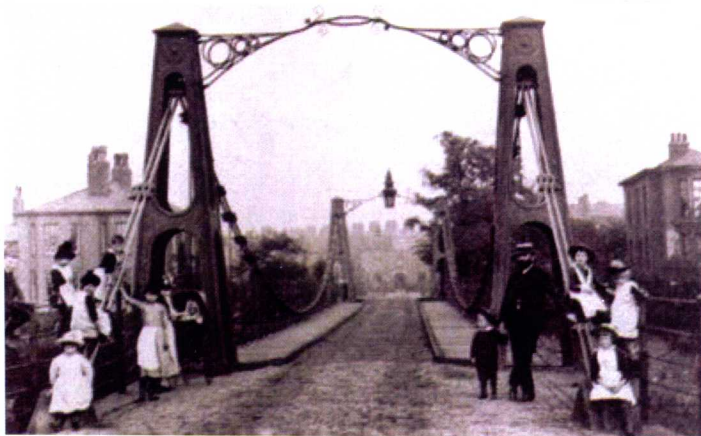
布洛顿桥垮塌后被立即重建并予加固
