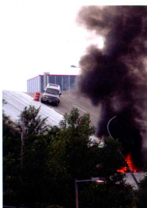
桥塌了，摔下河的汽车燃起大火！
