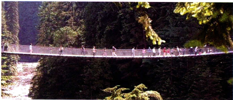
改进的吊板桥，平行的上层辅缆加强了桥面体系稳定性
