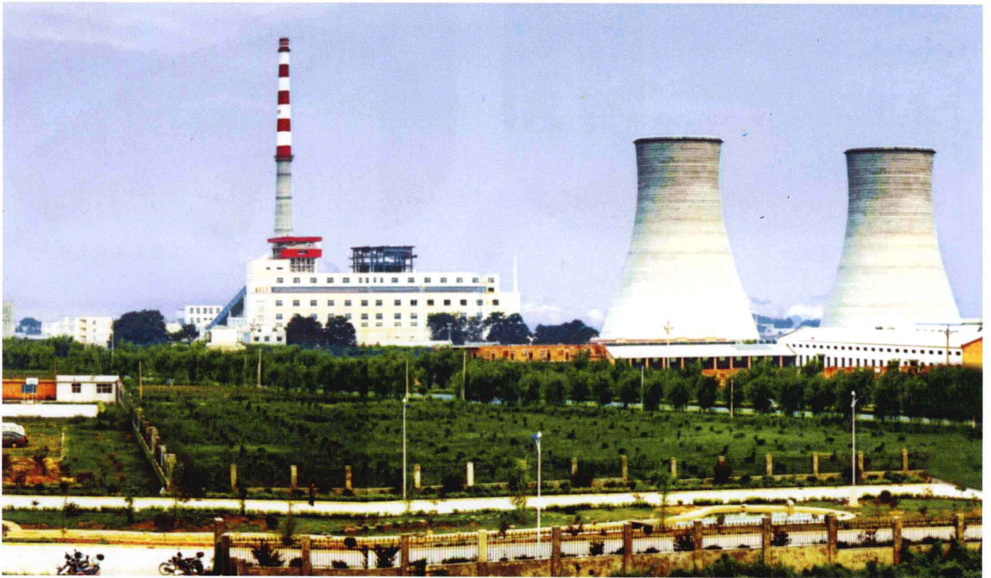
河南叶县蓝光煤矸石电厂
