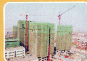
正在建设的御景尚都
