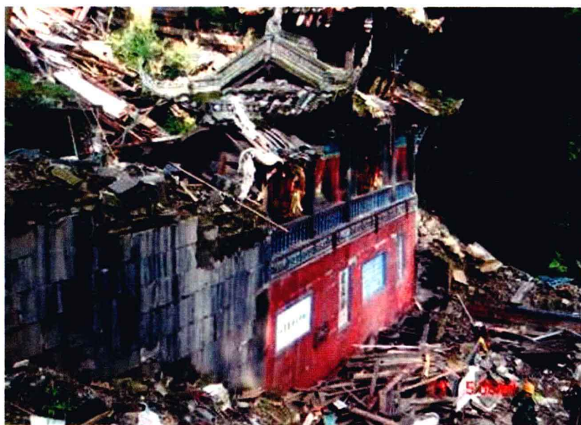
图 1-13 二王庙在地震中遭到空前的破坏
