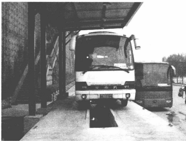
图1-24 汽车维修地沟
