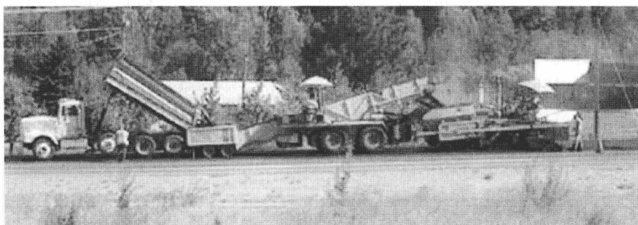
图 1-16 沥青摊铺过程车辆图(装载车、材料转运车、摊铺机)
