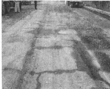
图 1-6 沥青路面的基层破坏
