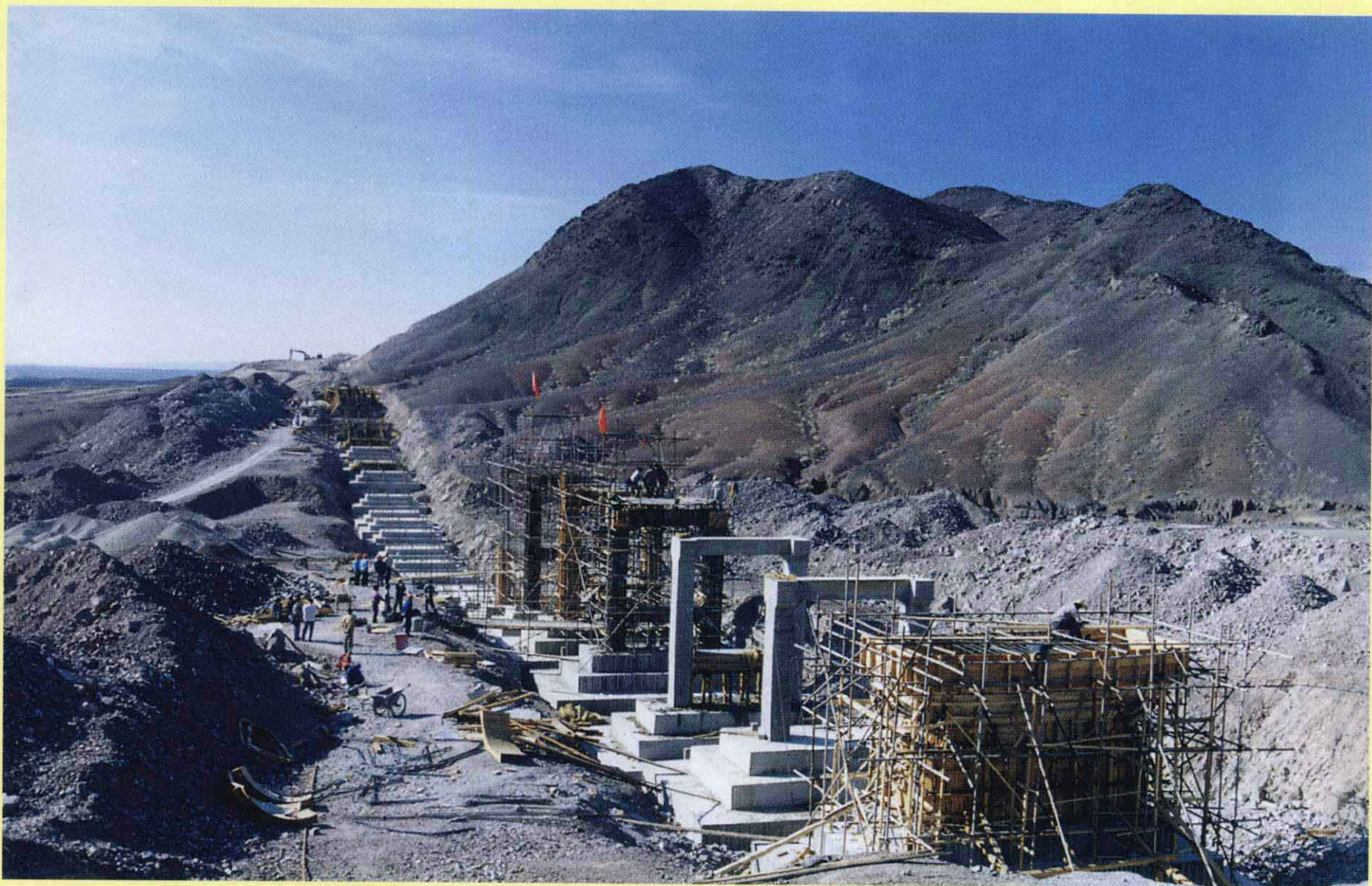
1998年,地质工程公司承担的“引额济克”引水工程风克干渠施工现场。
