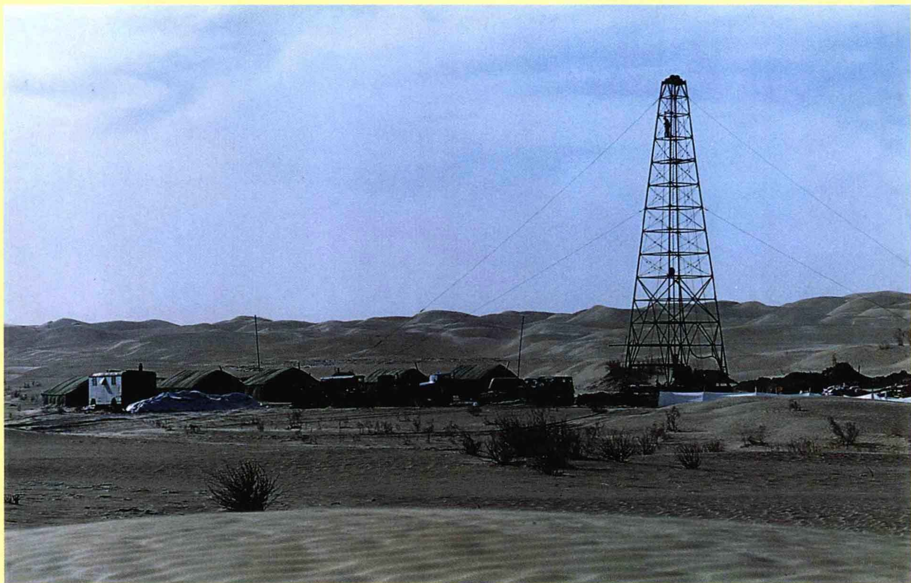
1996年3月,吐哈油田供水工程施工。
