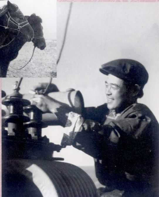
廷·巴 特尔正在修 理变压器
