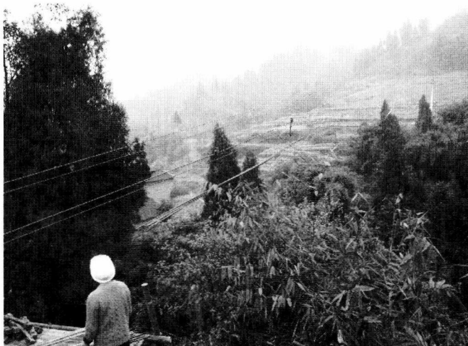
图 2-1 向一上工程索道运输现场
