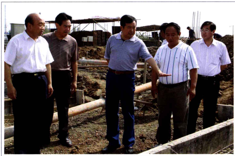
县委书记李彦军(中)深入县产业集聚区建筑工地视察
