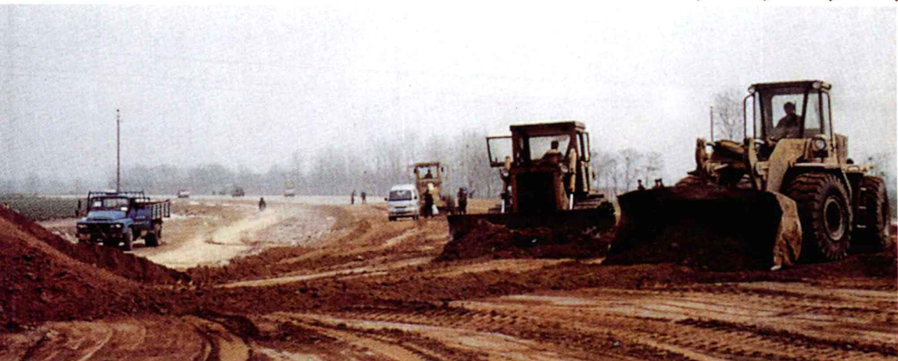
紧张施工的环城路建设工地
