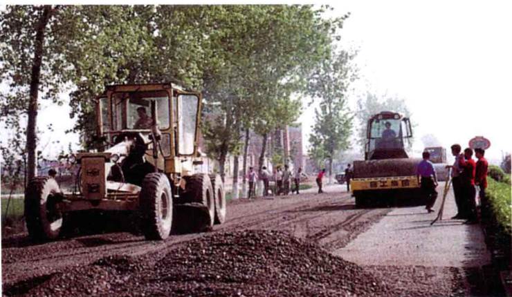
207 国道东半幅改建工程正在进行水稳层铺设
