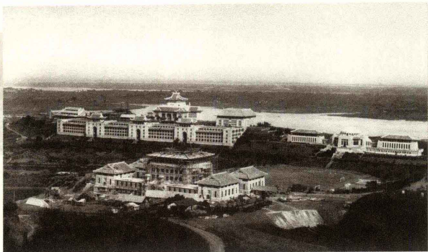
建设中的国立武汉大学珞珈山新校舍二期工程（1935年）
