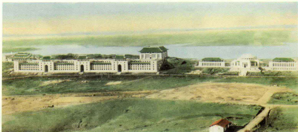
1931年底完工的国立武汉大学珞珈山新校舍一期工程部分校舍
