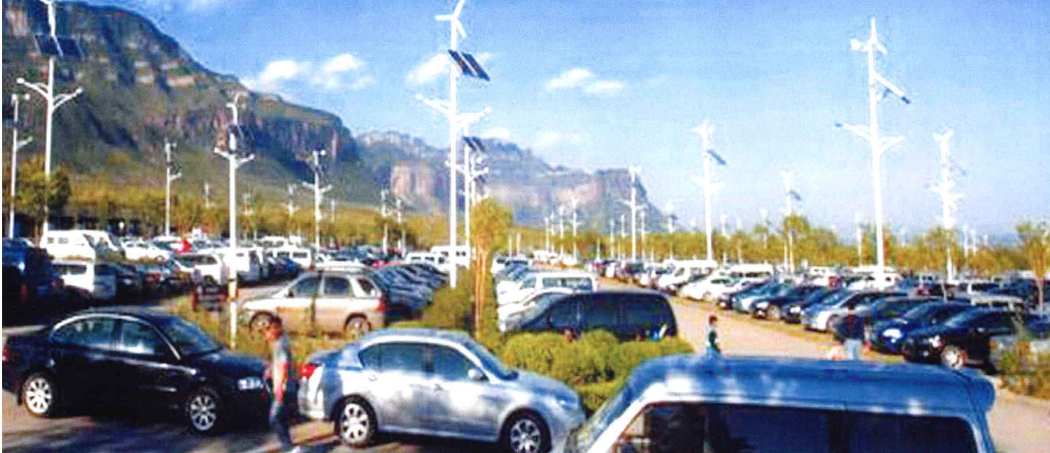
2010年9月30日，修武云台山景区在百家岩停车场投资310余万元安装的126盏“全永磁悬浮风光互补灯”正式投入使用
