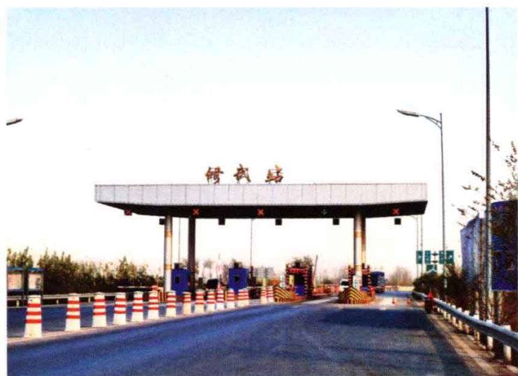
济东高速修武站
