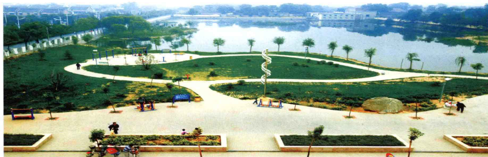
修武县白音潭游园
