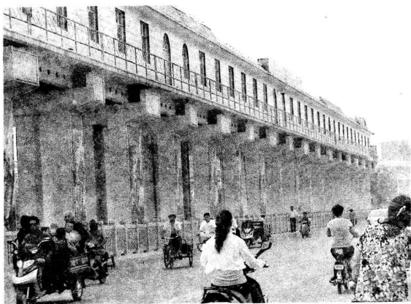
大跃进时期兴建的沈丘沙河大闸
